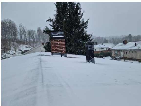
Visar snötäckt yttertak.
