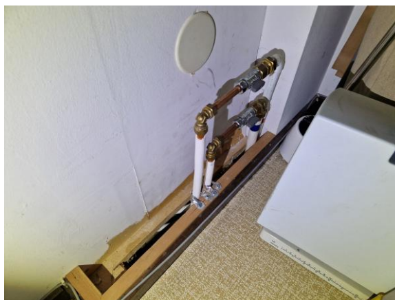
Fördelare till tappvattenrör i klk på övre plan.
