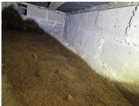
Grunden under entrén, endast besiktigad från ventil på grundmuren.
