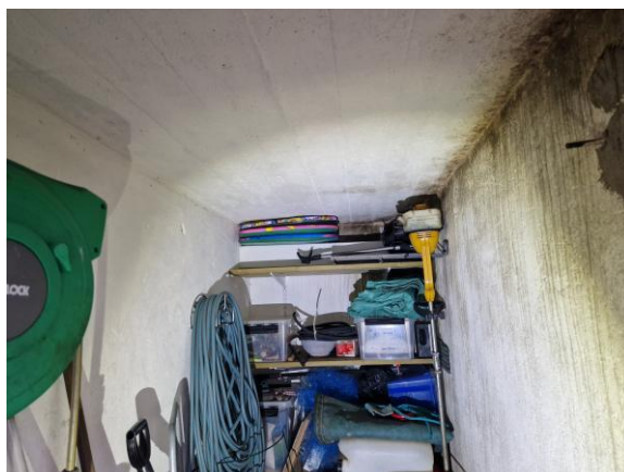
Kallförråd intill källaretrén.
