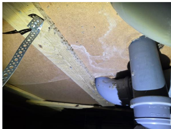
Överblicksbild, avlopp under dusch/wc.
