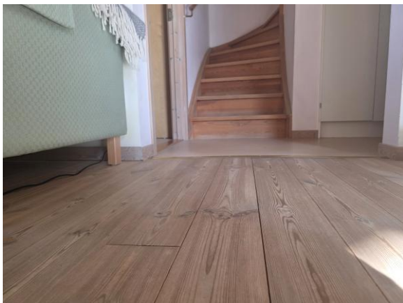
"Rygg" på golvet där sättning eller lutande golv upplevs.
