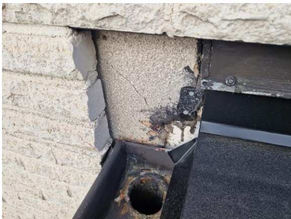
Otättheter mellan garagetak (vid hängrännan) och husfasaden.
