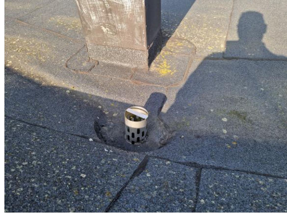
Yttertak - Viktigt att hålla takbrunnen rengjord så att vatten rinner undan, och det ej blir stående på taket.
