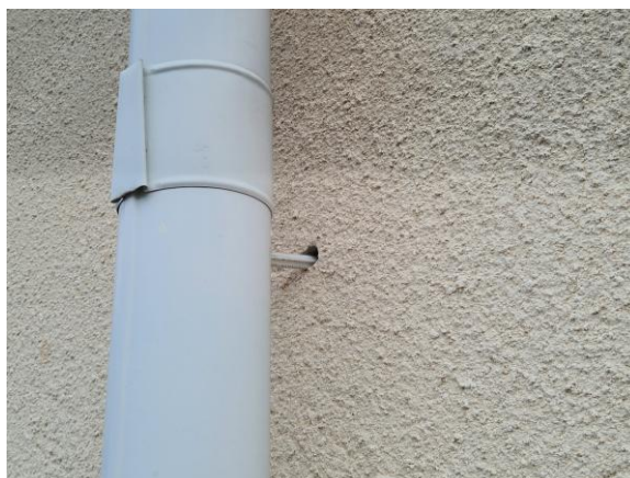
Otättheter förekommer på fasaden bl.a vid infästning av svep
