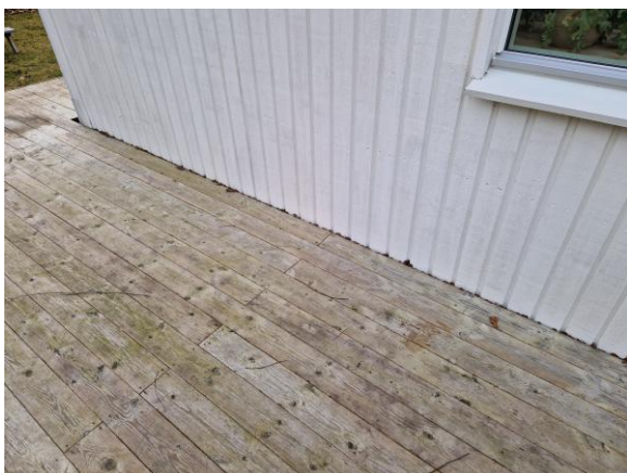
Altanen är vidbyggd mot fasaden.
