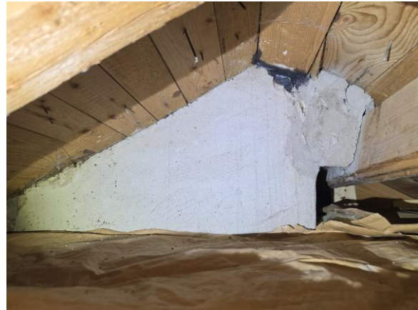
Vy över nockvind på den äldre delen.
