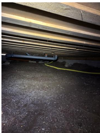
Vy kryppgrund tillbyggd del
