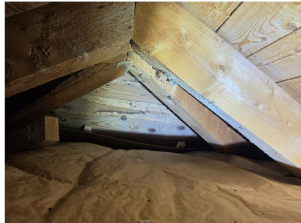
Vy över nockvind på den äldre delen.
