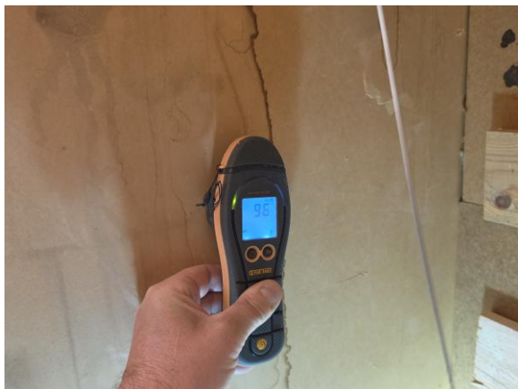
Spår av läckage på vägg i sidovind , inga avvikelser vid besiktning
