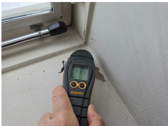
Spår av läckage vid takfönster, inga avvikelser vid besiktning
