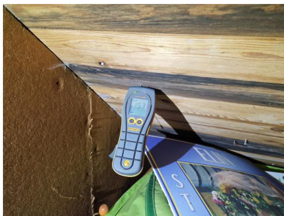
Visar fuktmarkeringar på underlagstaket, Inga förhöjda fuktkvotsvärden vid besiktningstillfället.
