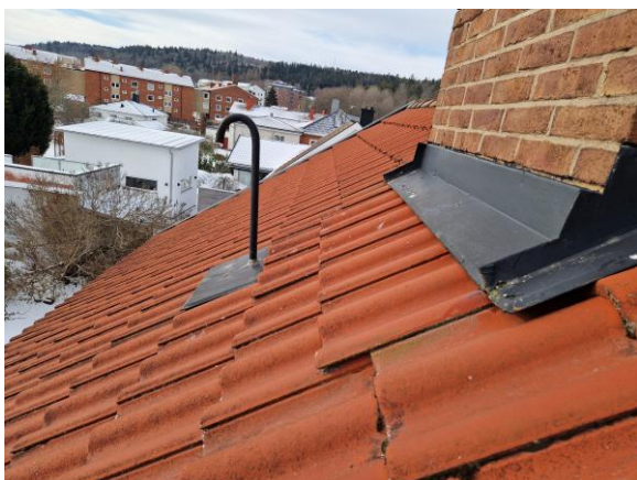
Vy yttertak från taklucka
