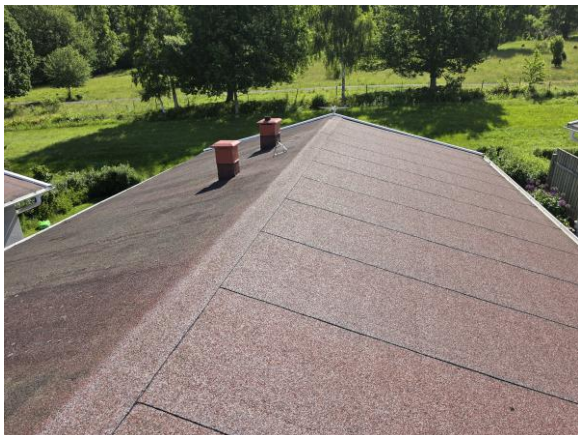
Vy över yttertaket.
