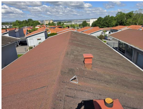
Vy över yttertaket.
