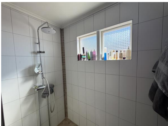
Fönster är placerat i våtzon1.
