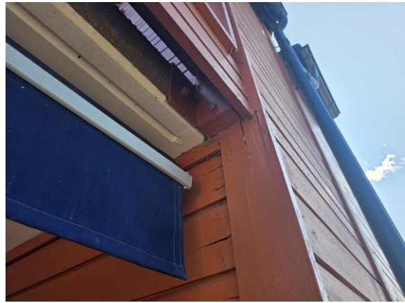
Bild på ytsidan av förrådsväggen under balkongen.
