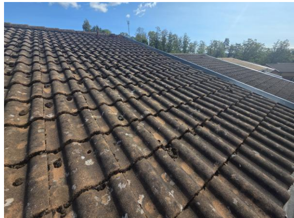
Översiktbild, äldre yttertak.
