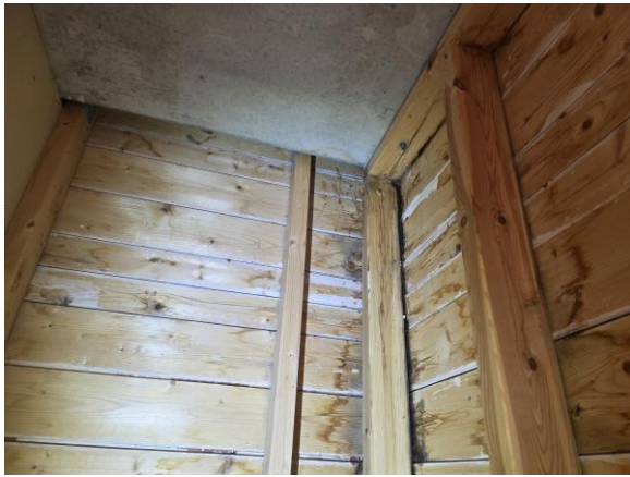
Bild på insida av förrådsväggen under balkongen.
