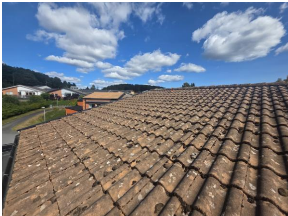
Översiktbild, äldre yttertak.
