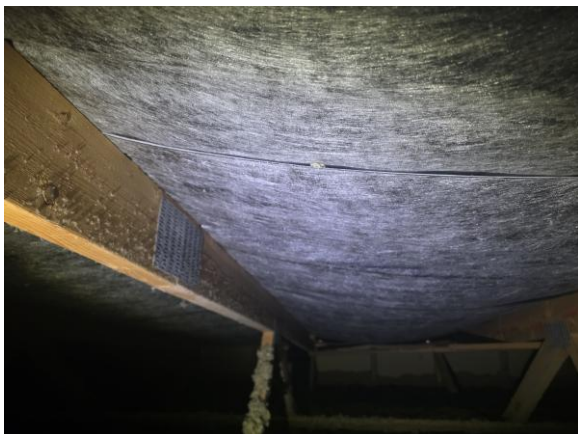
Bild på undersida av den frihängande underlagsduken. Skarvarna är överlappade men ej limmade.
