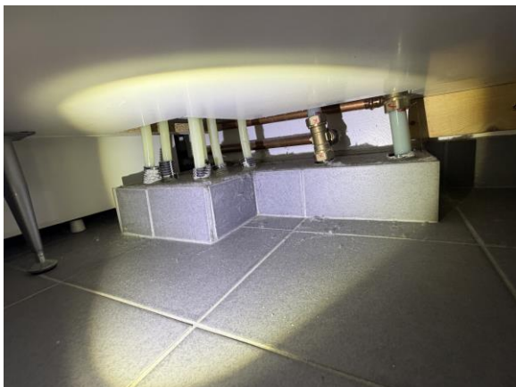
Rör genomföringar i uppgjuten klack i golv i tvättstuga.
