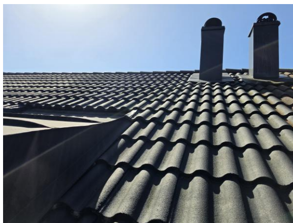
Vy över yttertak.
