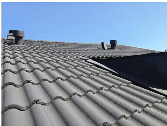
Vy över yttertak.
