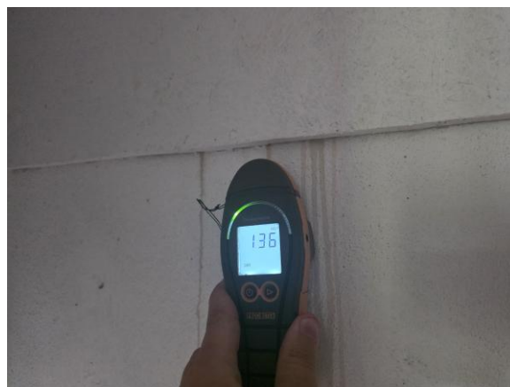
Rinnmärken på insida källaryttervägg i gästhuset, fuktindikering utförd utan avvikelse dvs. torrt i området vid besiktningstillfället.
