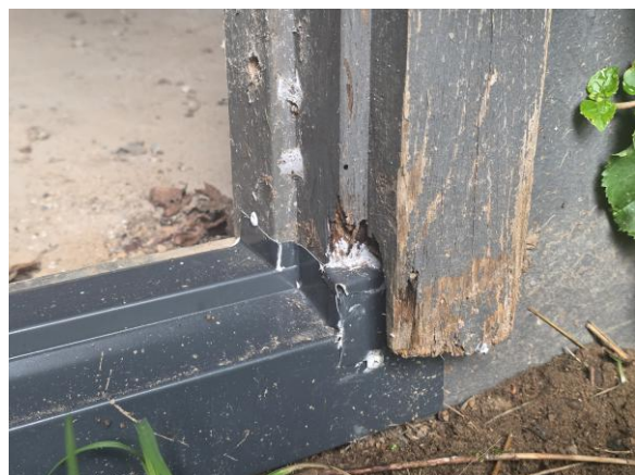
Fuktskador i källardörr, gästhuset.
