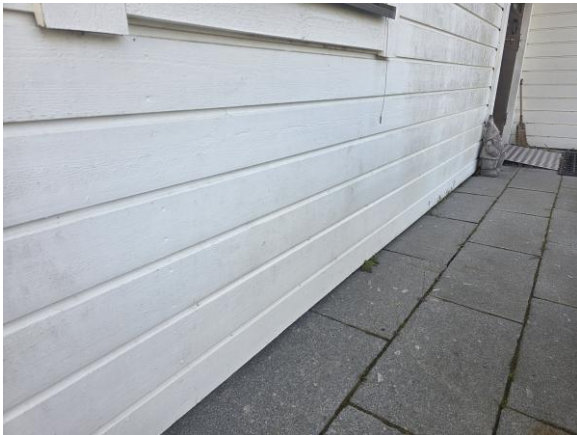
Delar av fasad avslutas nära mark.
