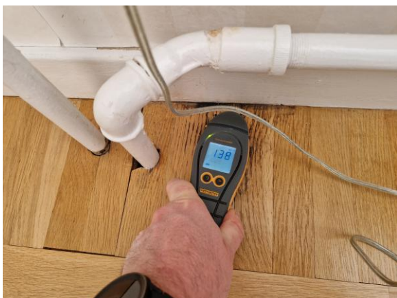
Visar fuktmarkeringar runt radiatorrör, Inga avvikelser
