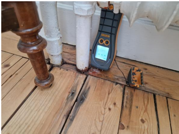
Visar fuktmarkeringar runt radiatorrör, Inga avvikelser
