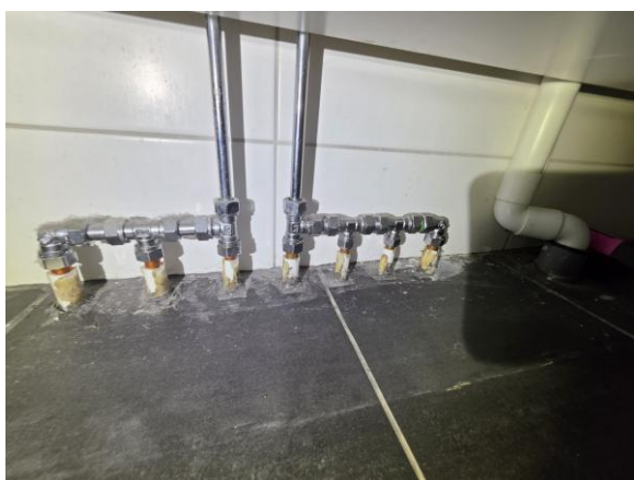
Rör genomföringar i golv finns i badrum på övre plan.
