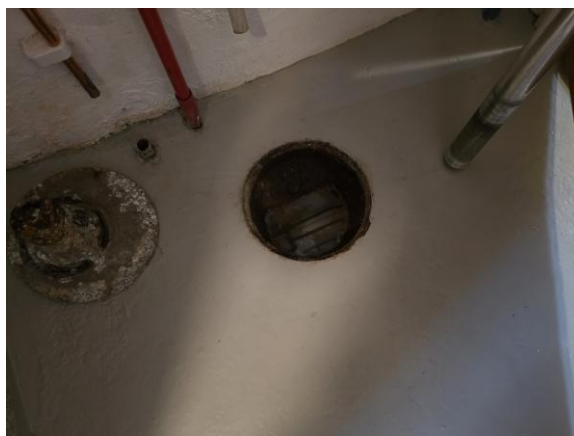
Spillvatten/skvallerrör från expansionskärl ej anslutet till avlopp eller golvbrunn.
